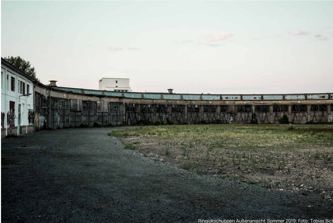
Ringlokschuppen Außenansicht Sommer 2019; Foto: Tobias Bick
