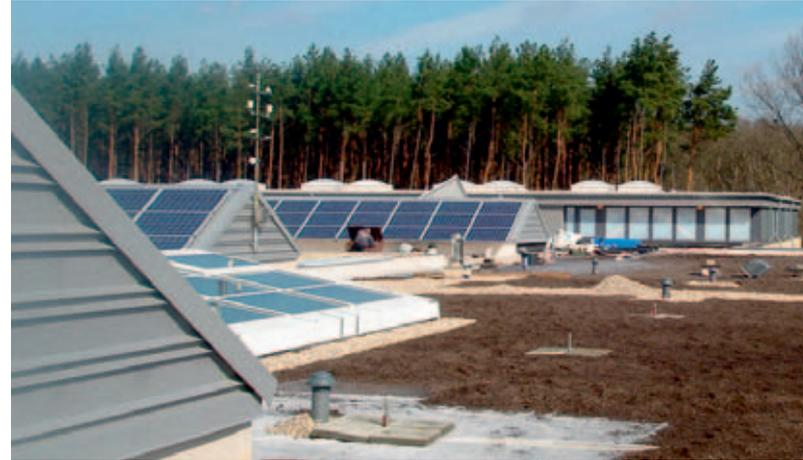
Abb. 31 | Die Photovoltaikmodule sind über der wasserführenden Schicht der Giebelbänder angeordnet. Die Räume darunter bieten Platz für die dezentral angeordneten Lüftungsgeräte.
