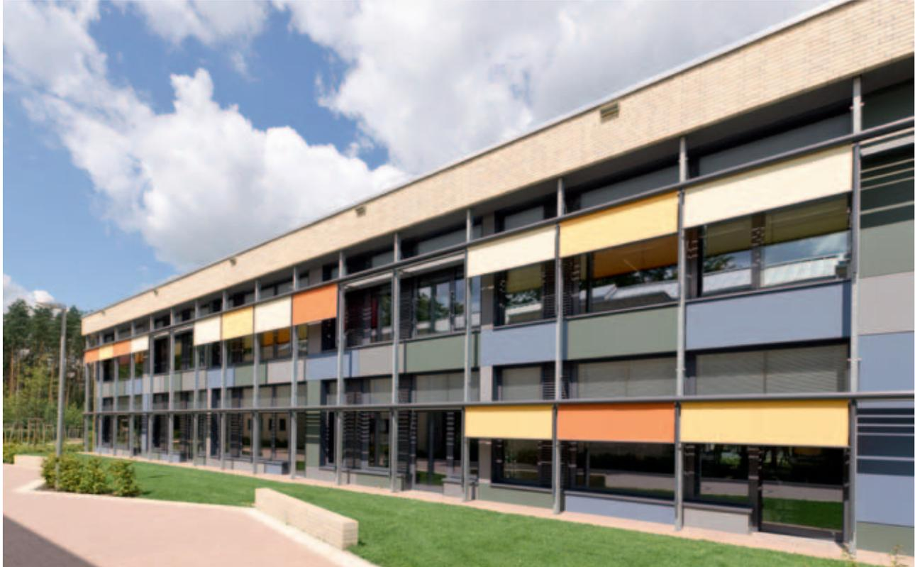
Abb. 34 | Fassade mit leicht regelbaren Verschattungselementen
