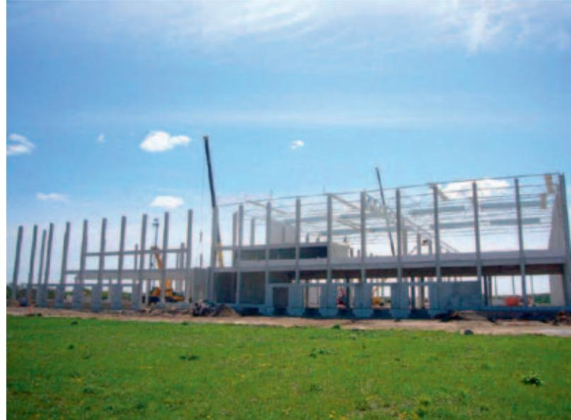
Abb. 22 | Stahlbetonskelett und Stahlträger während der Errichtung
