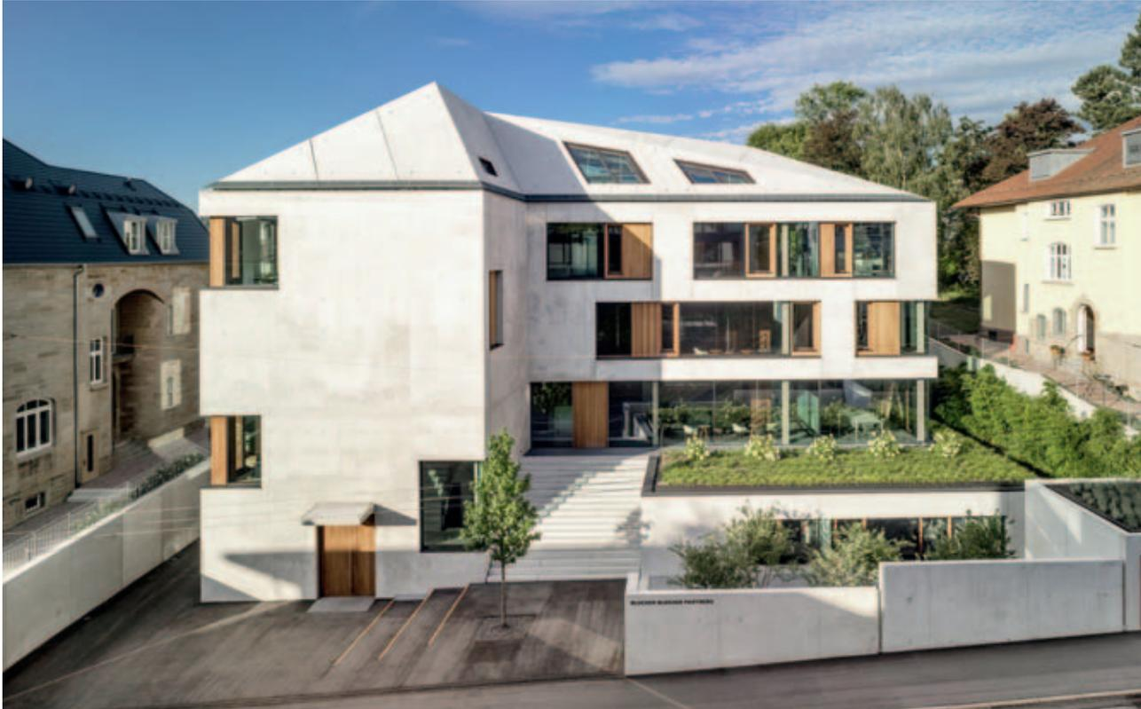
Abb.9 | Das Stuttgarter Bürogebäude mit Sichtbeton-Fassade und Faltdach aus großformatigen Betonfertigteilen.
