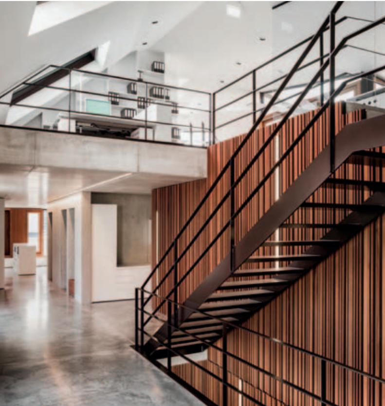
Abb. 12 | Einläufige Stahltreppe als geschossverbindendes Element
