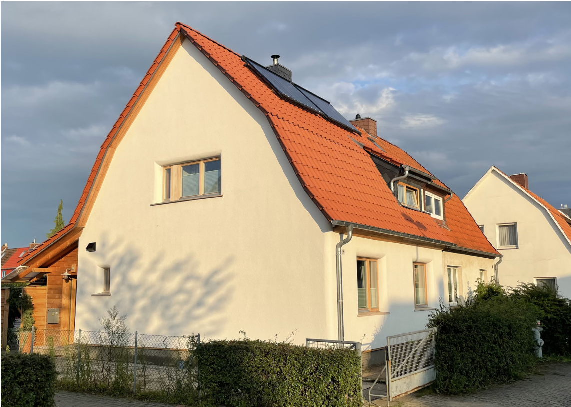
Doppelhaushälfte von 1927: DHH nachher (links), Nebengebäude nachher (letzte Seite), DHH vorher (unten links), Nebengebäude nachher (unten rechts)
