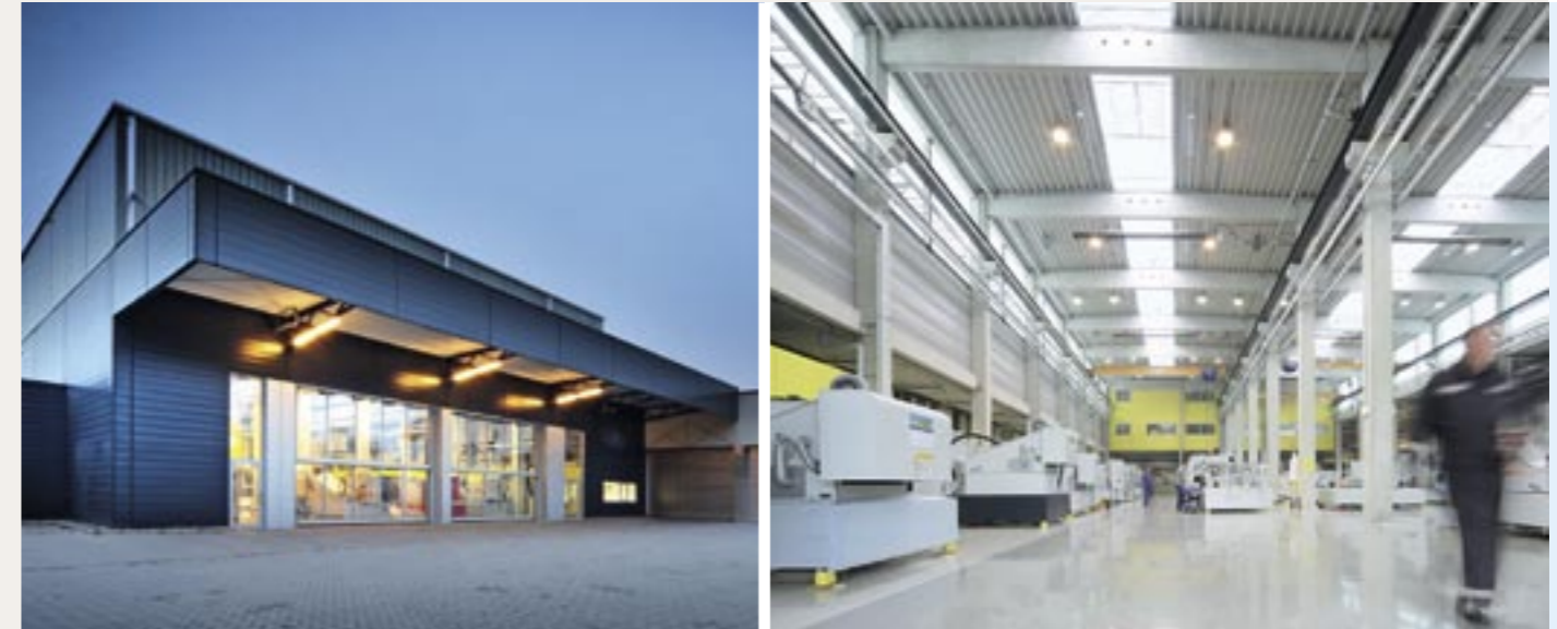
NEUBAU EINER MONTAGE-/VERSANDHALLE, LENGEDE ARCHITEKTEN: FT+ ARCHITEKTEN, BRAUNSCHWEIG FOTOS: BERNHARD JANITSCHKE
