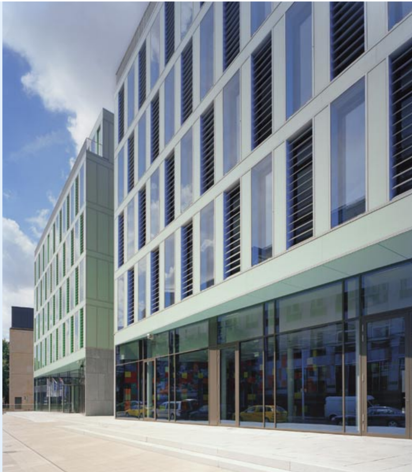
VGH VERWALTUNGSGEBÄUDE, HANNOVER ARCHITEKTEN: ASP ARCHITEKTEN SCHNEIDER MEYER PARTNER, HANNOVER FOTO: KLAUS-DIETER WEISS
