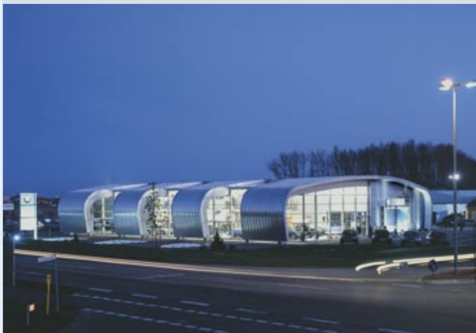
BMW-AUTOHAUS DIERKS, ZEVEN ARCHITEKTEN: WERNER BEHRENS ARCHITEKTEN INGENIEURE, ROTENBURG / WÜMME FOTO: FOTOSPEKTRUM TRAUTE MEYER
