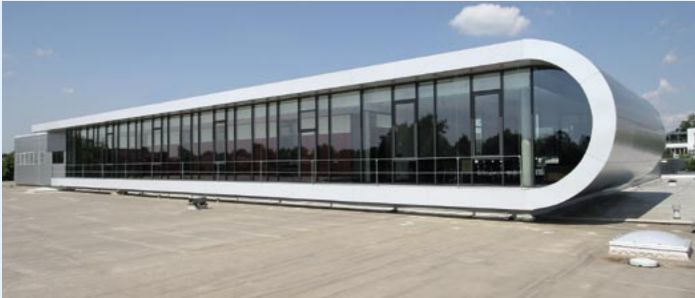
PHARMAGROSSHANDLUNG KEHR, BRAUNSCHWEIG ARCHITEKTEN: HSV-ARCHITEKTEN BDA, BRAUNSCHWEIG FOTO: ANDREAS BORMANN
